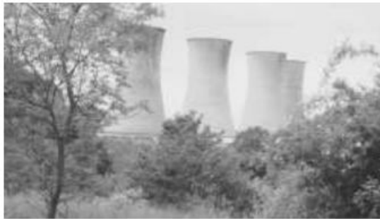
GEOTERMIA. Alcune torri refrigeranti in Valdicecina
