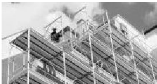
Un operaio a lavoro in un cantiere edile
