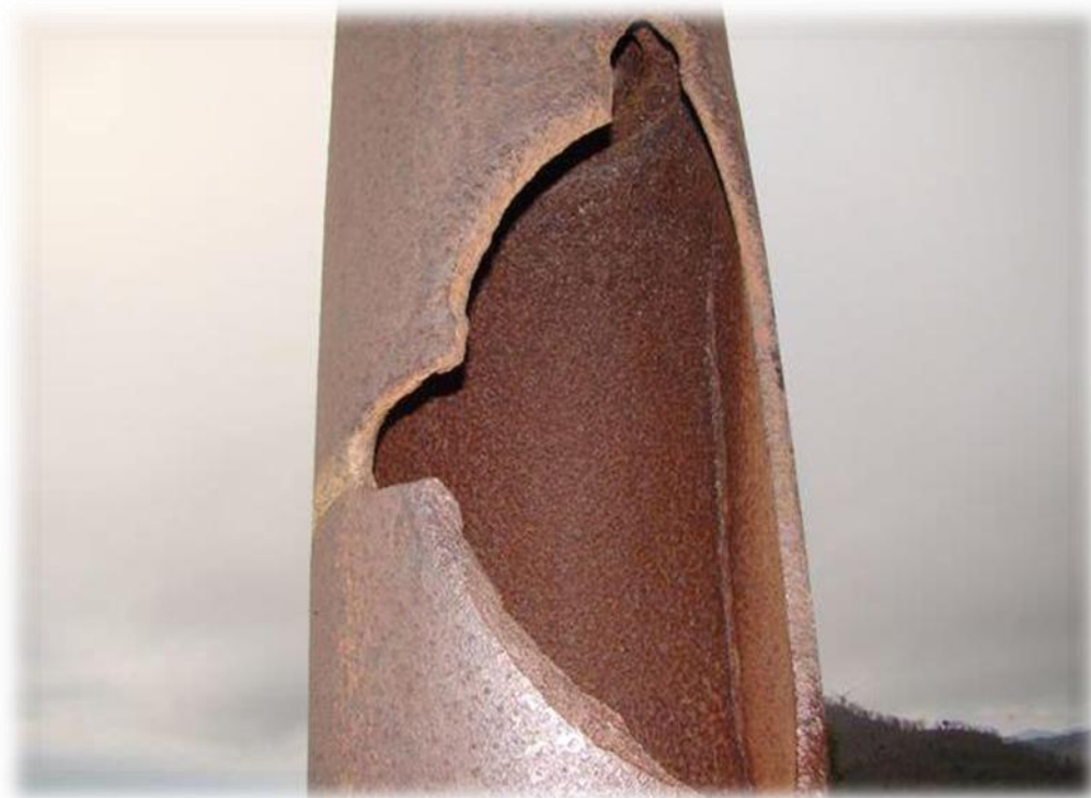
Una falla sullo stelo della Croce di notevoli dimensioni: il danno più consistente provocato dai colpi di cannone dell'ultimo conflitto. È localizzata a circa m. 1,70 dalla base; lo spessore della ghisa rilevato in quel punto è di mm. 20. Anche sul braccio destro della Croce è possibile notare una piccola 'ferita di guerra'.
