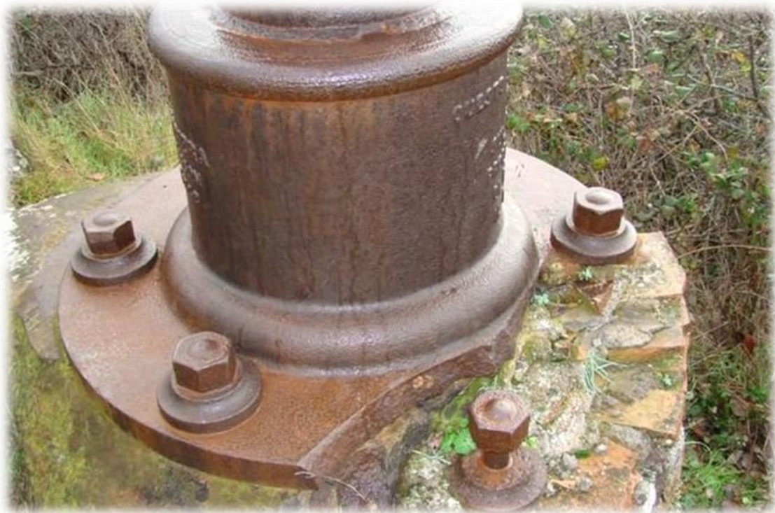
La base di fissaggio della Croce.
